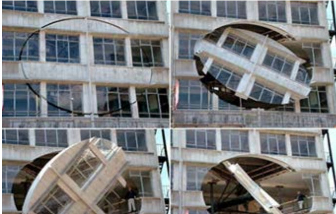
Transformasjon som kunst. Kutt i fasade skaper ny romlighet. Gordon Matta-Clark
